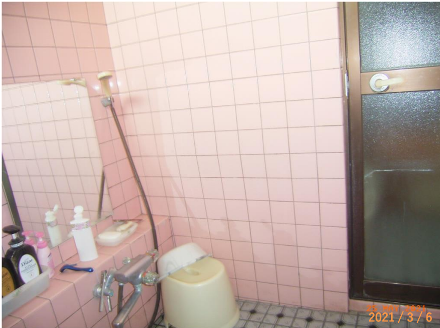
■現状写真■ (工事施工前)
